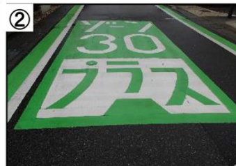
ゾーン30プラス路面表示
