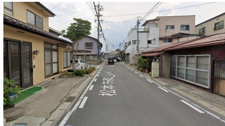
① 国道158号に並行する市道
